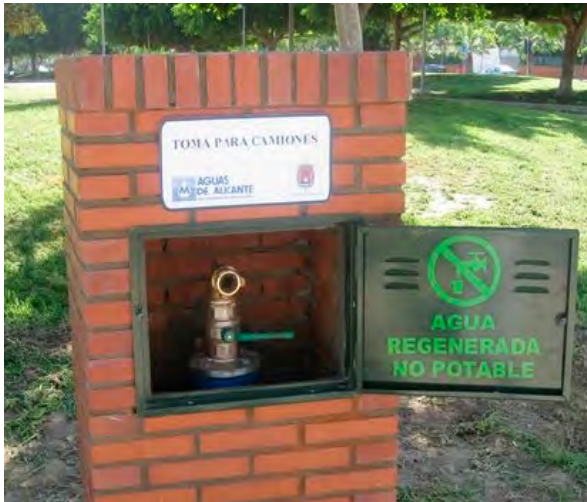
Abbildung 87: Entnahmestelle auf einem Park in Alicante mit violetter Rohrleitung und Warnhinweisen (Morote et al., 2019). Violette Warnschild auf einem dem „Campo Golf La Moraleja“ in Madrid (Madrid, 2023)
