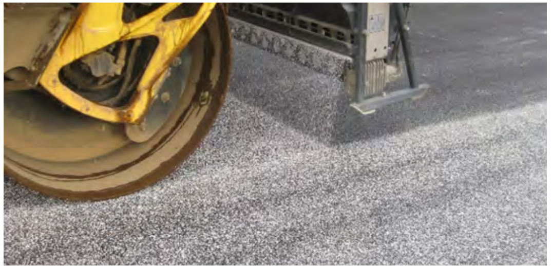
Abb.: Abstreuerung einer Asphaltdeckschicht mit hellen Gesteinskörnungen; © Ministerium für Verkehr Baden-Württemberg
