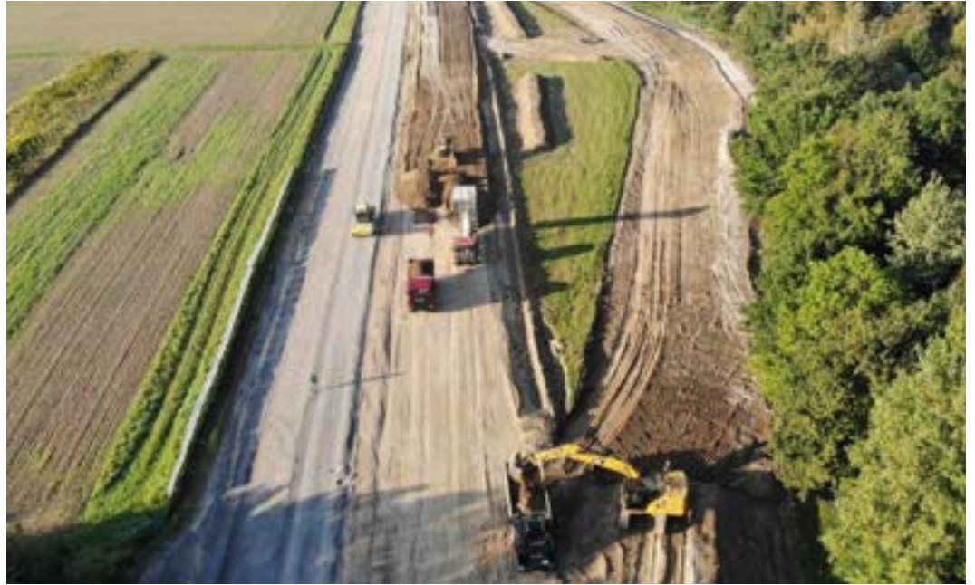
Abb.: Erweiterung/Ertüchtigung Hochwasserschutzdamm am Rhein; © IQG, Karlsruhe
