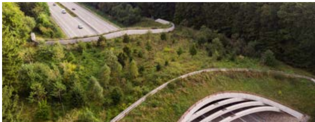
Abb.: Grünbrücke; © Martin Stollberg
