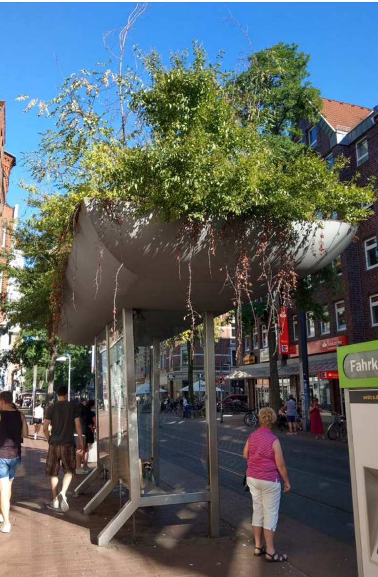
Abb. 5: Multifunktional: Bushaltestelle mit Begrünung bietet neben einem Unterstand auch Kühlung und optische Aufwertung. Die Maßnahme trägt zum Wasserrückhalt bei und verbessert die Luftqualität.
