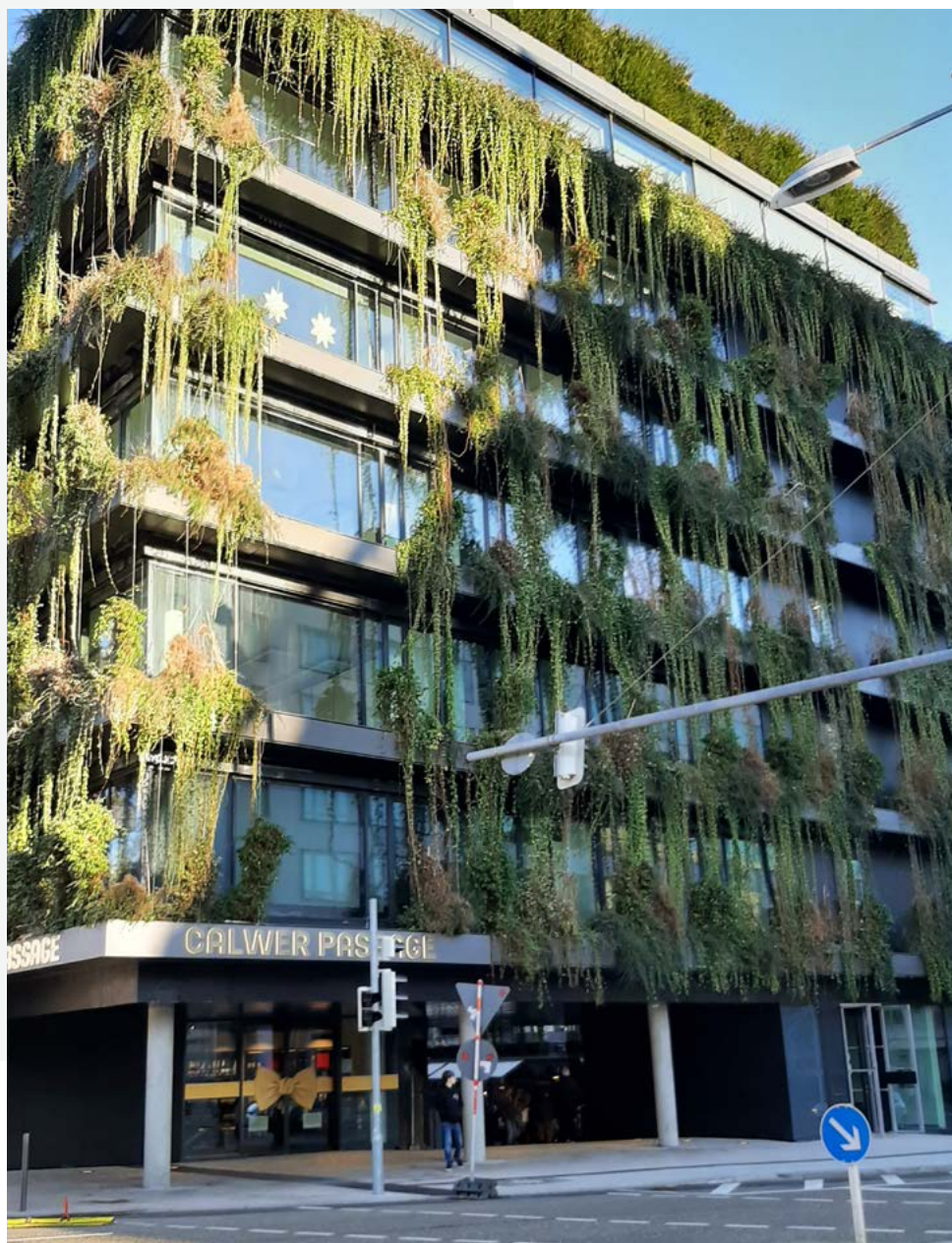
Abb. 6: Aktive Kühlung durch Fassadenbegrünung im Zentrum Stuttgarts.
